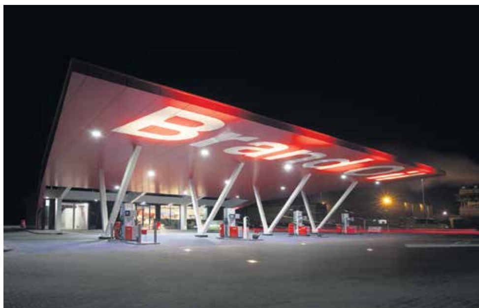
Plafond- en gevelbekleding tankstation Zutphen
